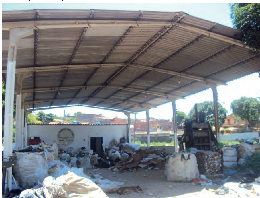
FIGURA 1 Galpão da Cooplum
